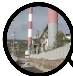
Εικόνα 8: Σταθμός παραγωγής ενέργειας της Δ.Ε.Η.
