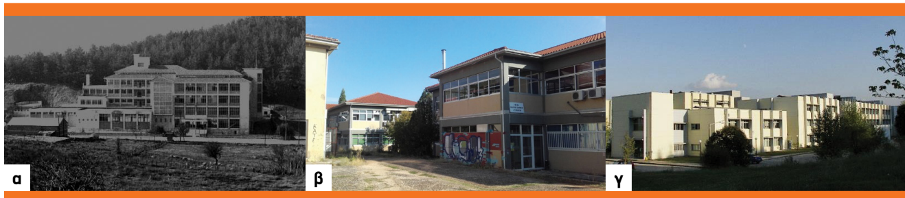
Οι τρεις φάσεις κτιριακής εγκατάστασης του Τμήματος Χημείας. Από αριστερά (α) Αρχική εγκατάσταση στο Κτίριο οδού Δόμοπολη (1976), (β) Στα 5 κτίρια προκάτ στην Πανεπιστημιούπολη Δουρούτης, (γ) Τα οριστικά συμβατικά κτίρια
